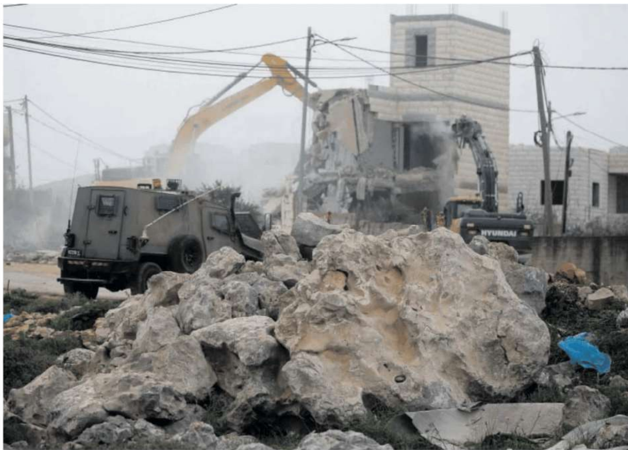
Una grúa demolía una construcción palestina en Nablus el lunes bajo la vigilancia de las autoridades israelíes. MOHAMMED NASSER (EP)
